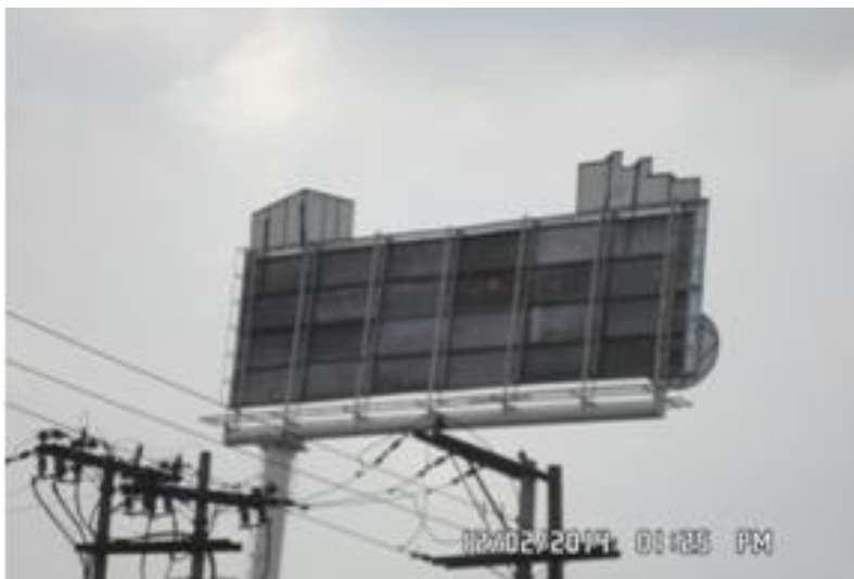
VALLA INSTALADA SENTIDO ESTE - OESTE
